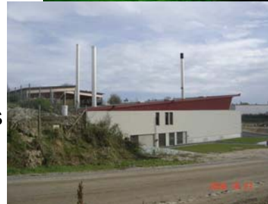
DSP Egletons, Limousin Réseau de chaleur Bois
