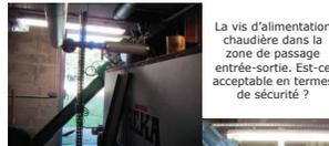
La vis d'alimentation chaudière dans la zone de passage entrée-sortie. Est-ce acceptable en termes de sécurité ?
