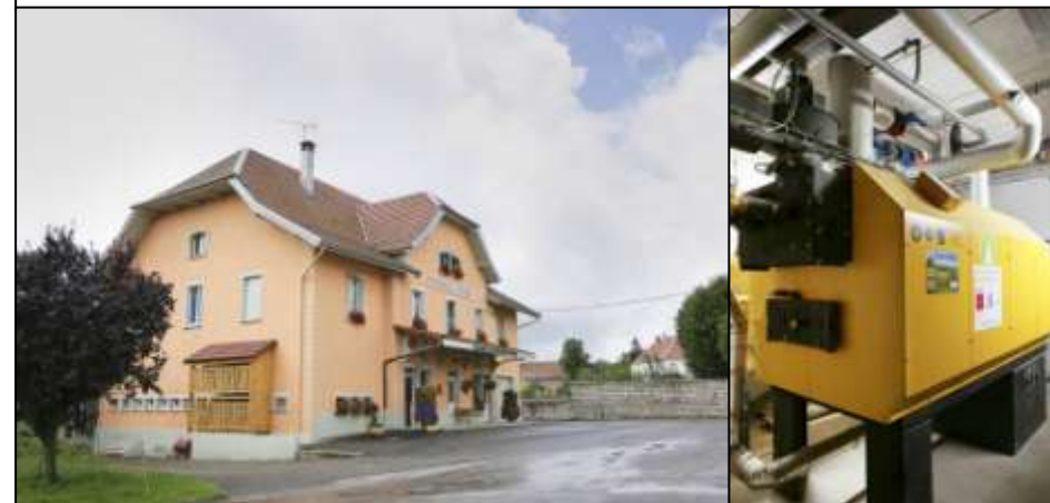
Fromagerie d'Epenoy (25), équipée d'une chaudière aux granulés de 300 kW
