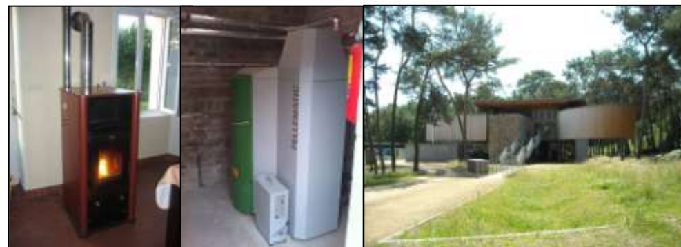
A gauche : poêle à granulés pour usage domestique, au centre : chaudière aux granulés de 35 kW, à droite : Maison des forêts à Saint-Etienne-du-Rouvray (76), chauffée par une chaufferie granulés
