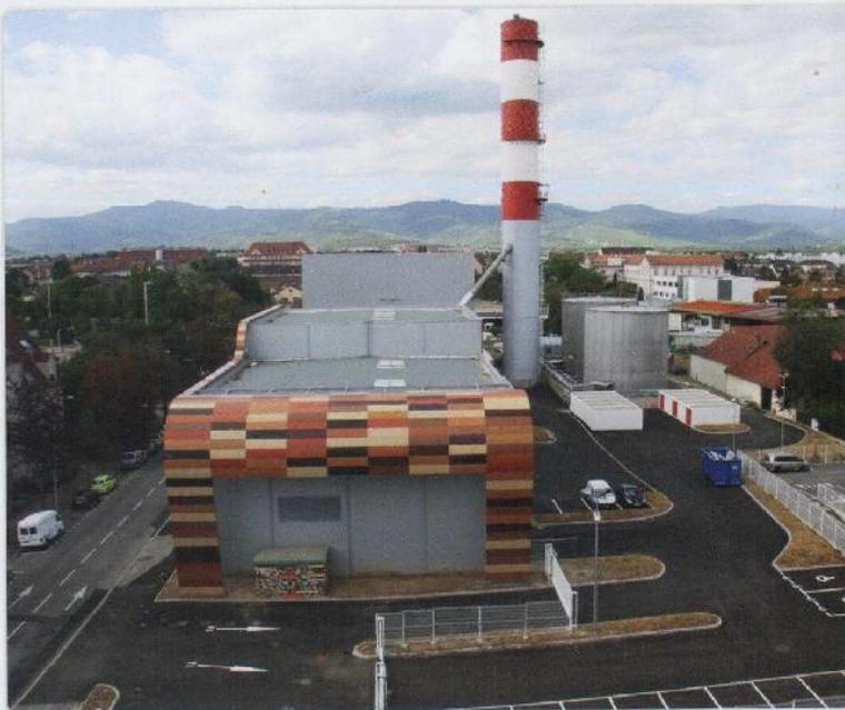
► La nouvelle chaudière biomasse de la ville de Colmar de 8 MW utilise 12 000 tonnes de plaquettes.
