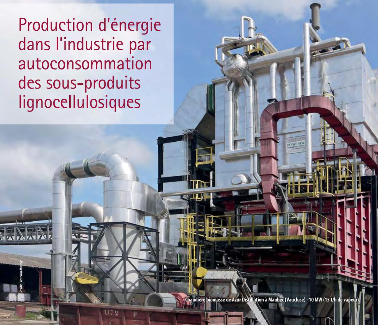
Chaudière biomasse de Azur Distillation à Maubec (Vaucluse) - 10 MW (15 t/h de vapeur).
