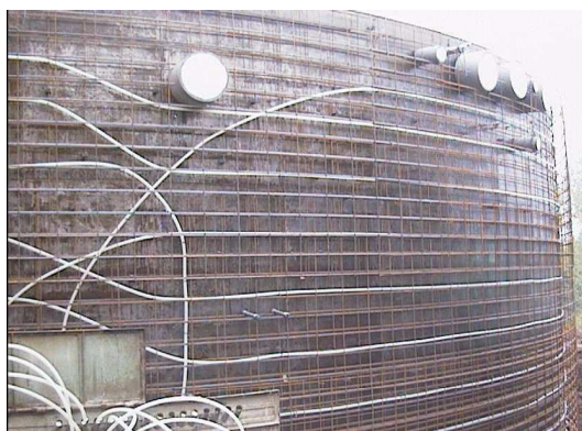
Fig.21. Tuyaux chauffants polymères et armature dans le mur du digesteur en
