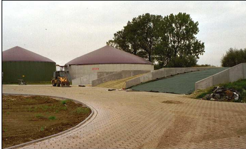
Fig. 10. Silo de transport près l'installation de biogaz
