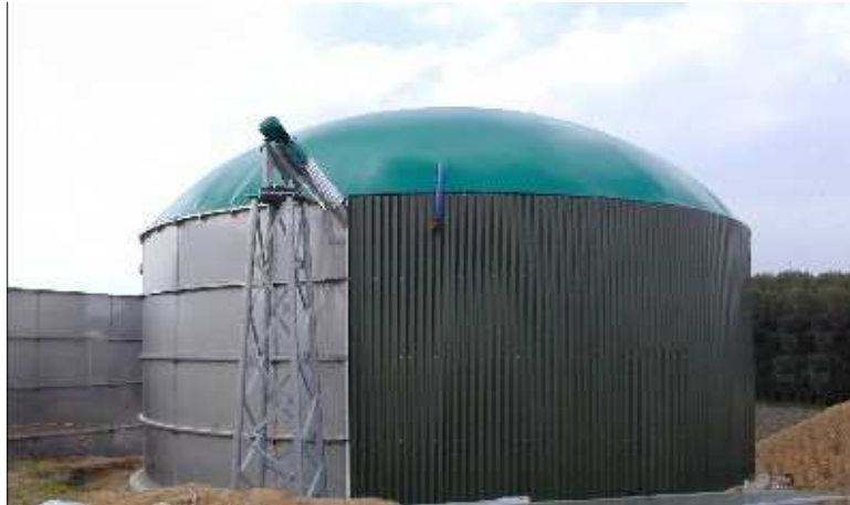
Fig.20. Digesteur en acier précieux en construction.
