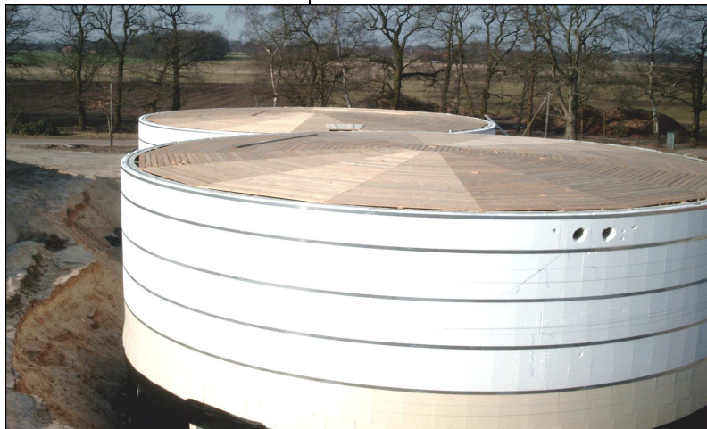
Fig. 19. Digesteur en béton avec isolation.
