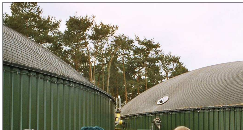
Fig.37. Coupole en folio sur le digesteur de conservation de biogaz
