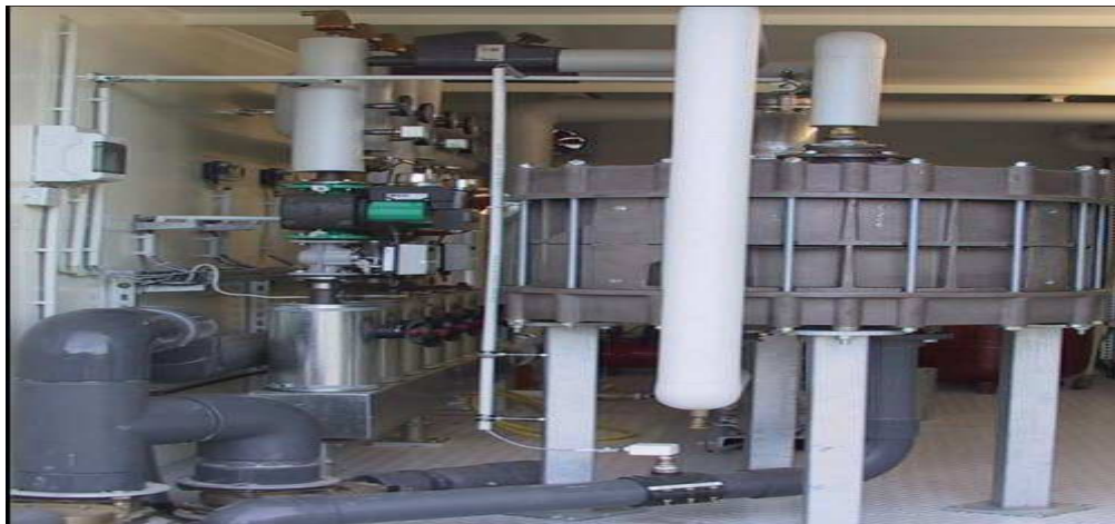
Fig.23. Echangeur thermique de type "spirale"
