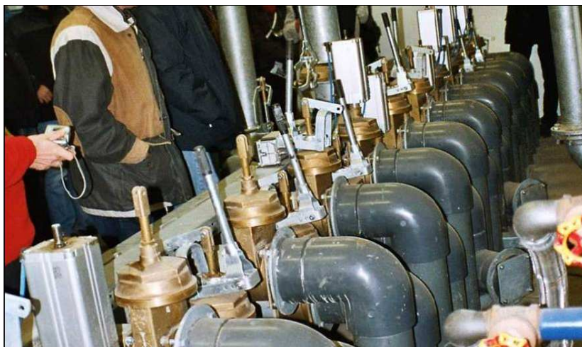
Fig.31. Mécanisme central de distribution du substrat.
