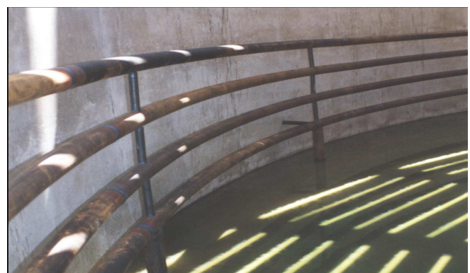
Fig. 22. Tuyaux chauffants en acier.
