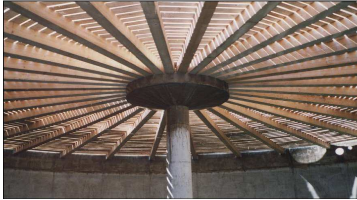
Fig.38. Construction en bois pour soutenir la coupole.
