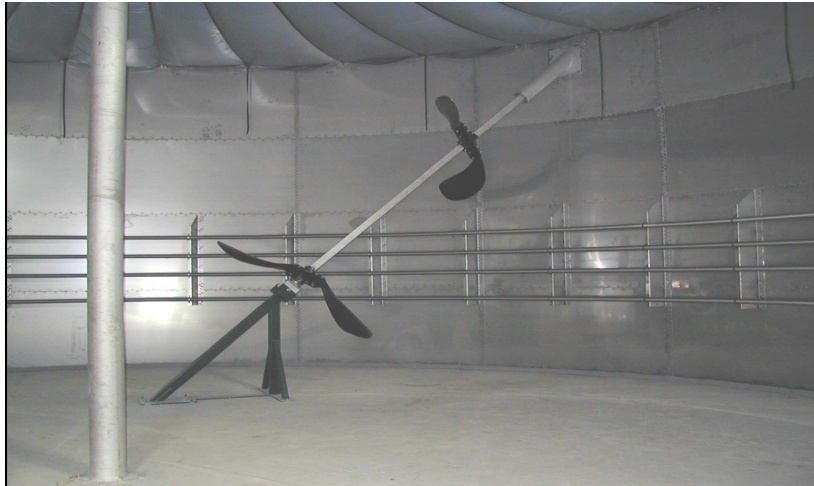
Fig. 24. Mélangeur en spirale.
