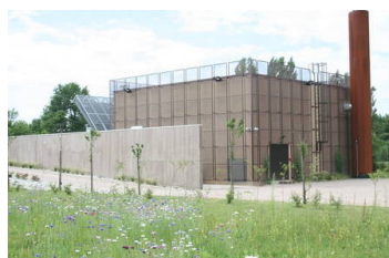
Chaufferie de Négrepelisse source : ville-negrepelisse.fr
