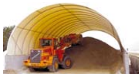
Surélévation de la structure sur des murets.
