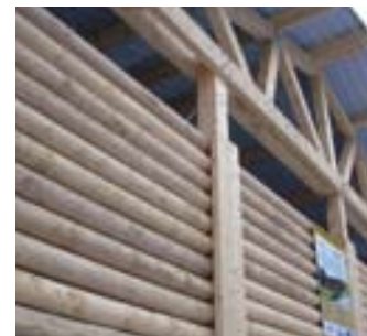
Parois en rondins usinés.
