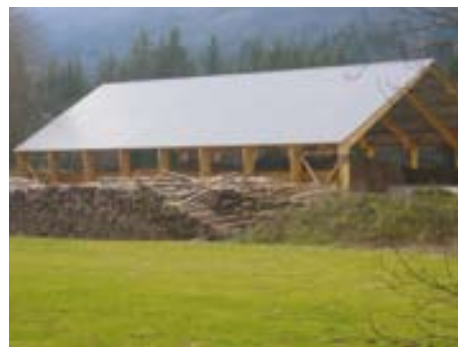
Hangar de M. Ponta (Jura).
