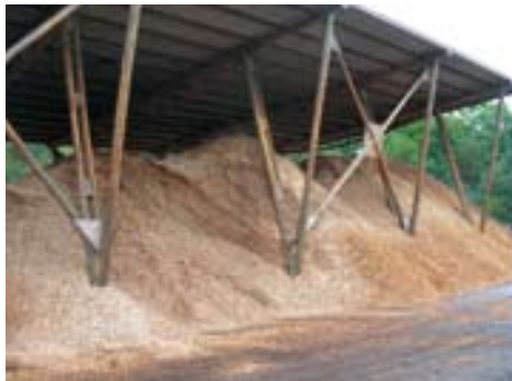
Hangar de Lausanne.
