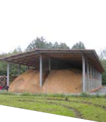
Hangar bois énergie de Bières en Suisse.
