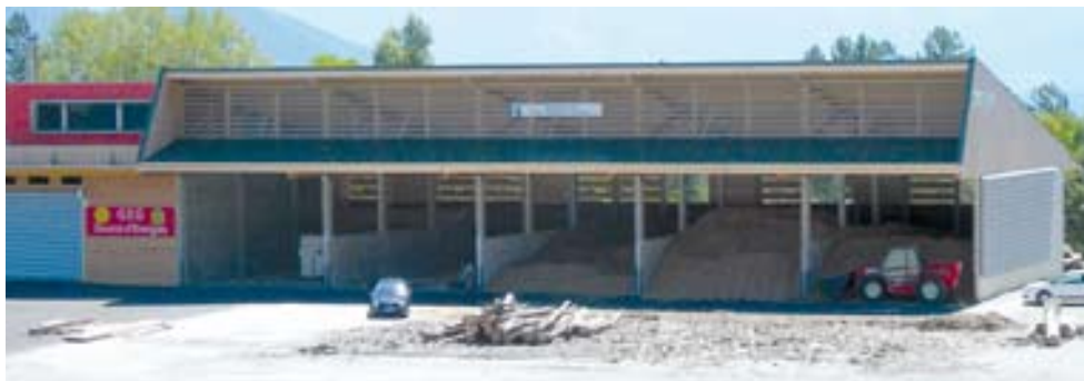
Hangar de St Michel les Portes (Trièves).
