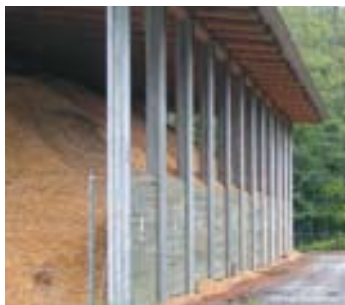
Parois en bastingas empilés.
