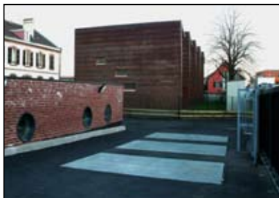
Les trappes du silo enterré du lycée Paul-Émile Victor à Obernai (67)
