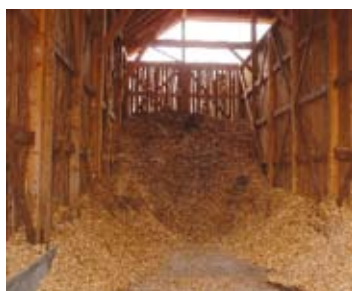
Hangar de stockage à Mollau (68)
