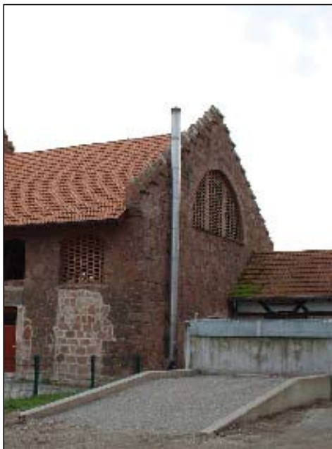
Accès au silo de la chaufferie de la Ferme Bussière à Strasbourg
