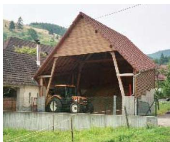
Hangar de stockage à Griesbach-au-Val (68)
