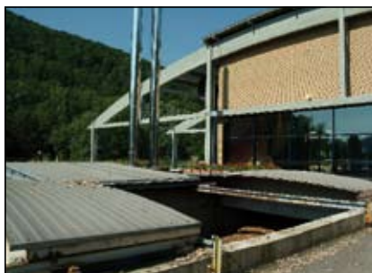
Couvercle coulissant du silo de la piscine de Kaysersberg (68)
