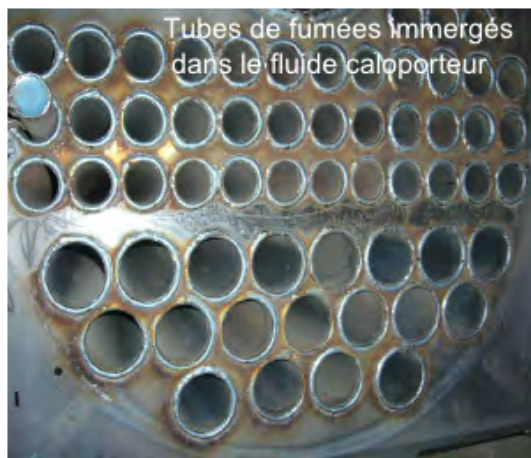
Figure 16 : Echangeur de chaleur à tubes de fumées (Source : Biomasse Normandie)
