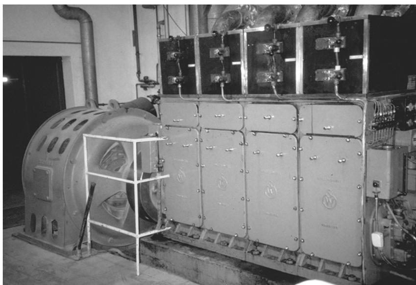
Autre particularité du site, le générateur d'électricité est un moteur à vapeur, de marque Spilling.
