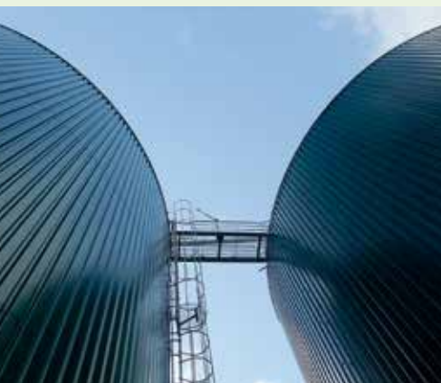
Digesteurs à biogaz.
