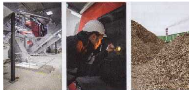
Deux chaudières bois, et trois à terre, fournissent 60 % des besoins du réseau de chaleur du Grand Dijon.
