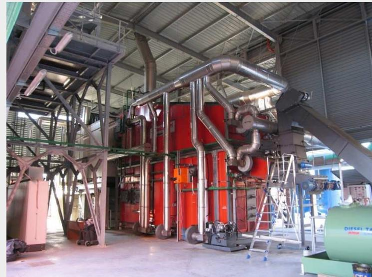
Ces 2 installations font 5 200 kW et produisent du fluide thermique à 320 °C pour des cogérations ORC
