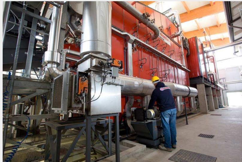
Chaudière fluide thermique de 5 200 kW
