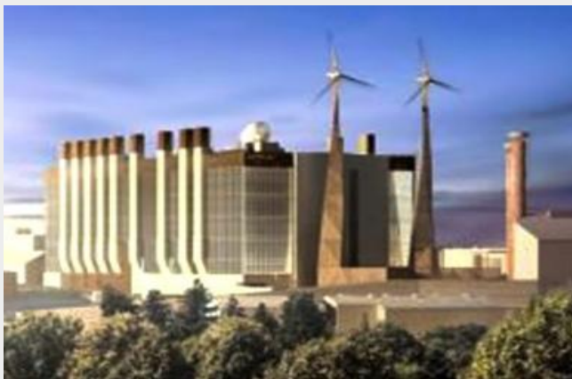
BskyB London (UK) 10CCHP Turboden
