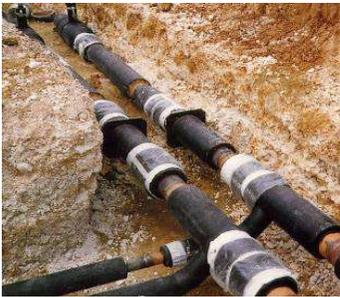
L'énergie est distribuée sous forme d'eau chaude par un réseau de canalisations isolées et enterrées.
