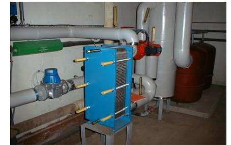
Le raccordement de chaque usager du réseau se fait par un **échangeur**, situé dans une sous-station équipée d'un compteur à calories.
