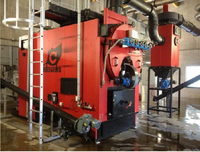
Chaudière bois avec rendement de 90%
