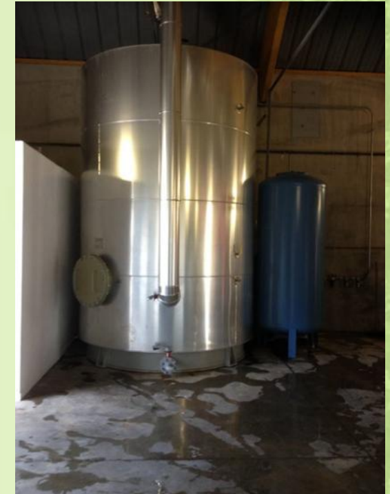
Ballon de stockage des calories
