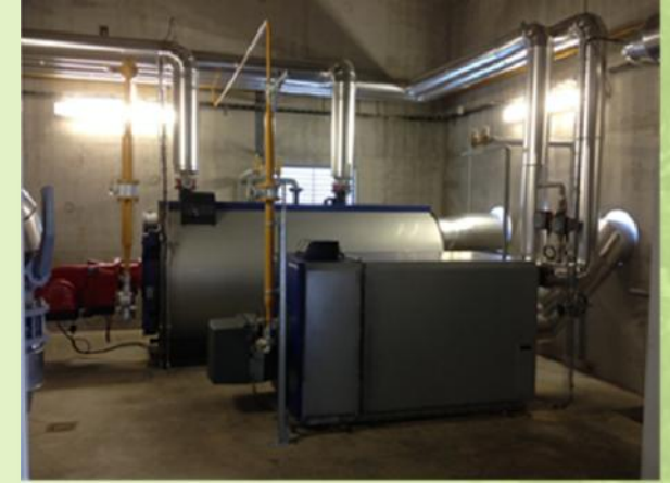
Générateurs de secours
