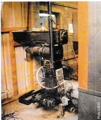
Ecluse rotative coupe-feu entre la vis de transfert et la vis d'alimentation de la chaudière
