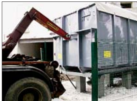
Dépose du "conteneur-silo" sur le quai
