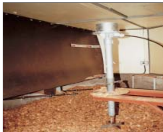
Trémie dans laquelle se vide le conteneur à racleurs. (Les plaquettes bois sont ensuite acheminées depuis cette trémie jusqu'à la chaudière par un système de convoyage par vis sans fin).
