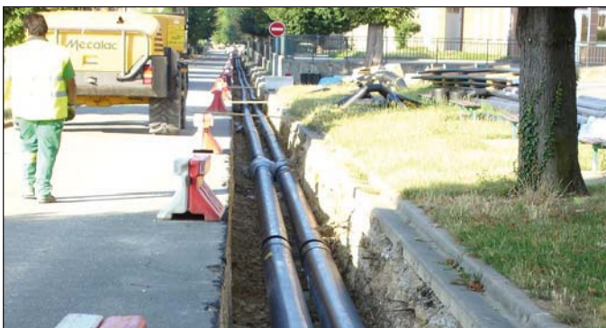
Tranchées réseau de chaleur.
