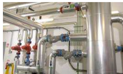
Circuit hydraulique de distribution de la chaleur
