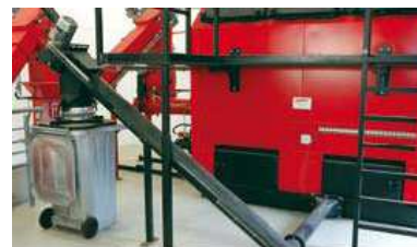
Chaudière bois de 0,6 MW avec décendrage automatique par vis
