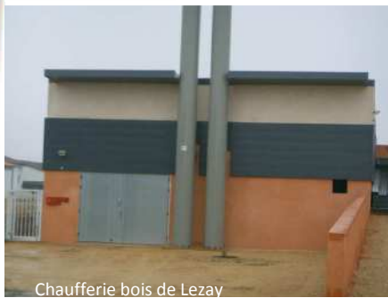
Chaufferie bois de Lezay
