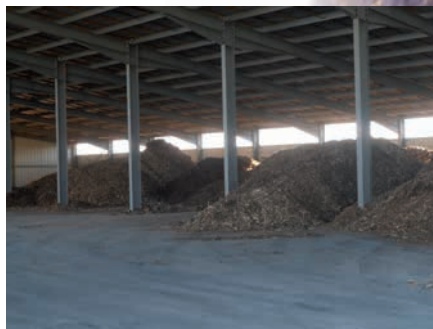
Hangar de stockage de la plaquette
