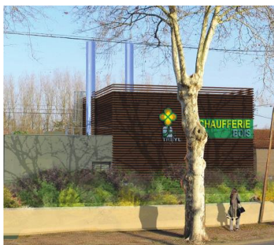
Vue d'une chaudière bois Crédit photo : TRIFYL
