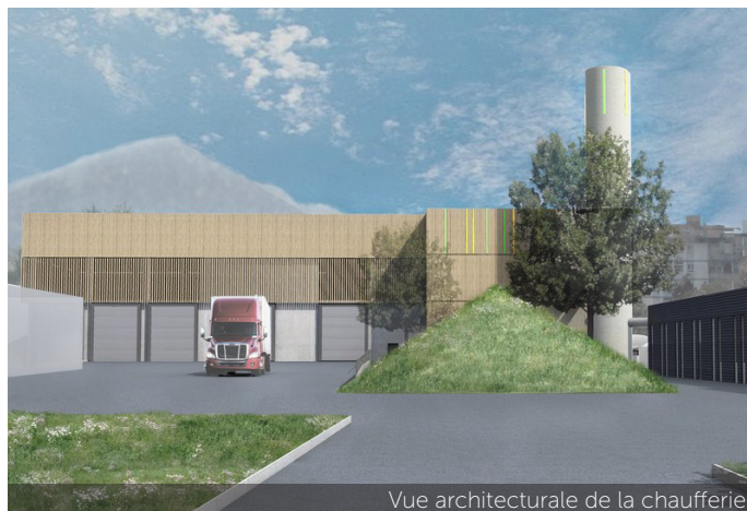
Vue architecturale de la chaufferie
