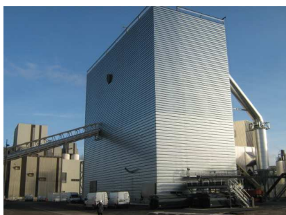
Bâtiment chaudière biomasse
