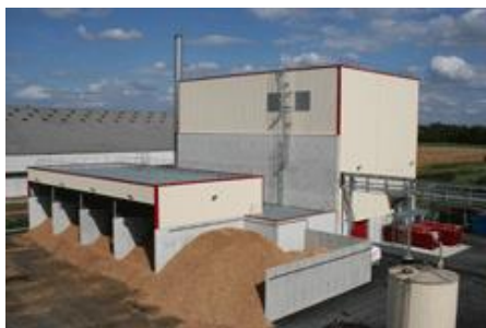
Chaudière Biomasse Site Buchères Source : DISLAUB
