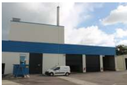
Chaudière biomasse crédit photo : photothèque DALKIA
