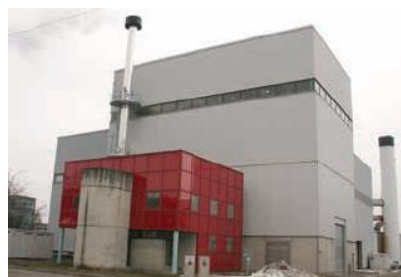
L'ensemble de la chaufferie qui abrite le stockage et la chaudière
