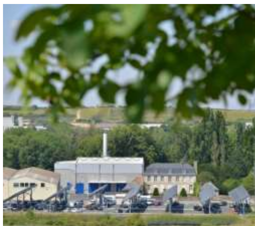
Vue de la chaufferie biomasse et d'une partie des panneaux solaires installés sur le parking de l'usine
