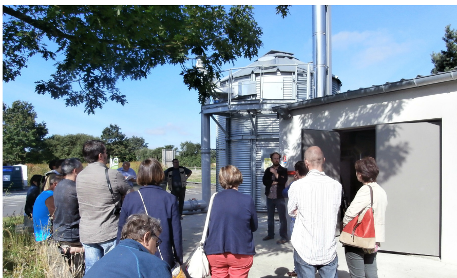
Le bois est stocké dans un silo à grains à l'entrée du pôle enfance. Le réseau, long de 350 m, est enterré. La chaleur est émise via des planchers chauffants ou des radiateurs à eau.
