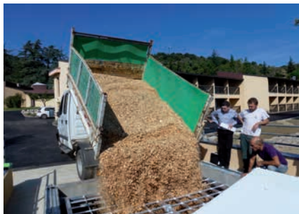
Bennage gravitaire dans le silo
