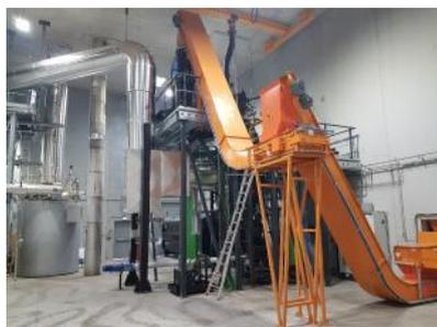
Le gazéifieur de biomasse COGEBIO peut également être associé à un moteur afin de permettre la production combinée d'électricité et de chaleur.
