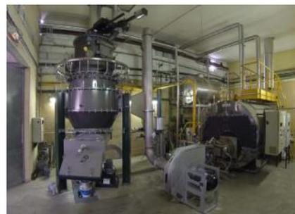
L'association du gazéifieur COGEBIO et du brûleur GASFLEX est particulièrement intéressante dans le cadre de la substitution de combustible fossile sur une chaudière vapeur ou sur une chaudière à huile thermique car elle offre de nombreux avantages : utilisation de la chaudière existante, suivi aisé des appels de puissance, arrêts et démarrages rapides, choix du combustible selon l'évolution des prix, rentabilité économique, faibles émissions atmosphériques...
