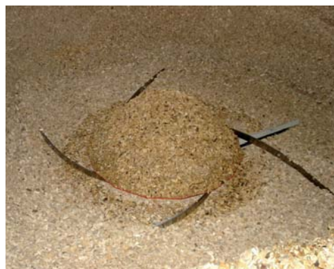
Intérieur de silo chaudière bois
