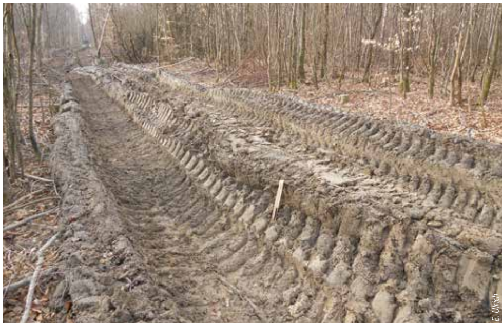
Après la fin du débardage (ornièrre > 30 cm)
