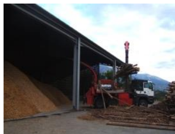
La plate-forme de bois déchiqueté de la Communauté de communes de Serre-Ponçon.
