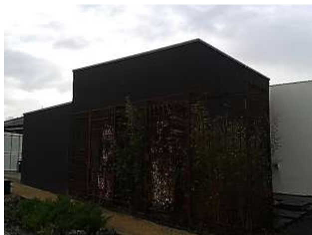
Chaufferie Bois du Crédit Agricole de Serres Castet. Chaufferie à gauche, silo à droite et trémie de remplissage enterrée sous le capot tout à droite.
