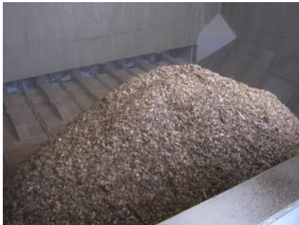
La chaudière brûle exclusivement des plaquettes forestières.
