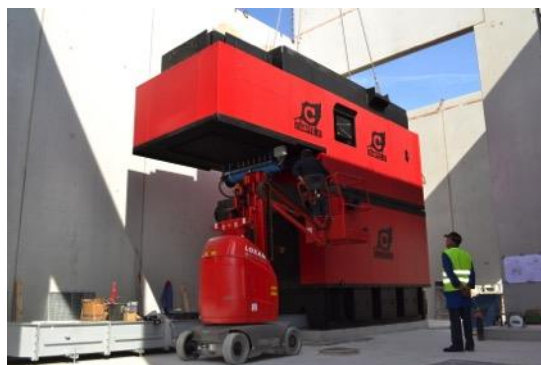
Mise en place de la chaudière bois de 3,3 MW
