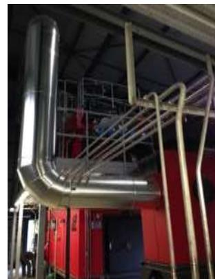
*La chaudière est équipée d'un dépoussiéreur multicyclones et d'un électrofiltre.*
