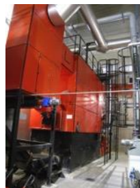
La chaudière bois Weiss de 2,4 MW
