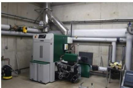
Les 2 chaudières bois fonctionnent en cascade afin de maximiser le taux de couverture bois et d'éviter l'usure des équipements par du sous-régime.
