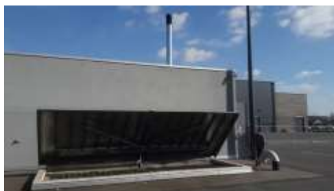
Chaufferie de Sceneo
