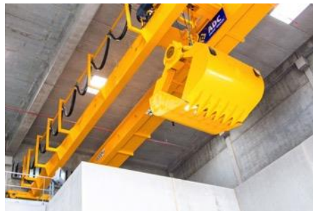
Le grappin du silo semi-enterré
