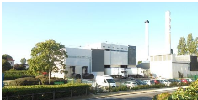
Photos chaufferie : Célia Robert / Dalkia
