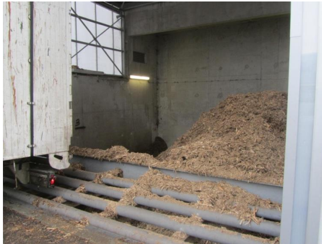
Exemple d'une modification de silo permettant un meilleur déchargement
