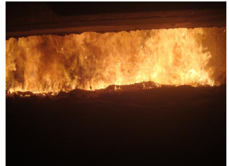
Foyer de combustion sur une chaudière à projection de bois (« spreader-stoker ») pour une cogénération biomasse (25 MW PCI) (photo JMB - 2018)
