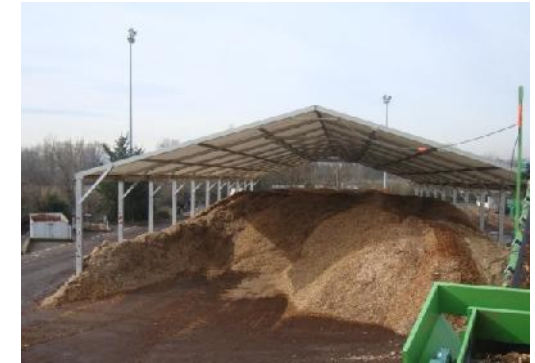
Exemple stockage plaquettes bois sur plateforme sous abris (photo JMB - 2013)
