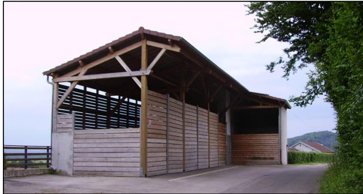
FIGURE 1: PLATEFORME DE STOCKAGE COMMUNALE (GENNES, 25) - SOURCE: PRO-FORET
