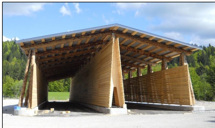
FIGURE 3: PLATEFORME DE STOCKAGE DU SYNDICAT MIXTE DU CANTON DE MOREZ (LA MOUILLE, 39)
