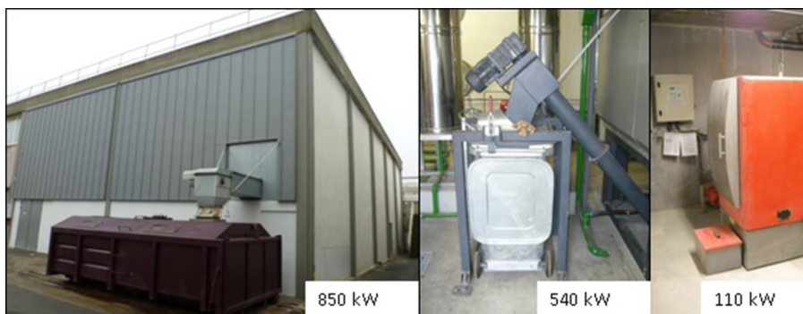
▲ Figure 22 : Bac à cendres sous foyer (de gauche à droite : 8 m 3 , 300 litres, 20 litres)
