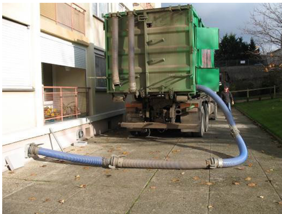
▲ Figure 11 : Exemple de stockage aérien avec chargement pneumatique
