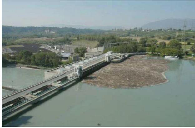
Photo 16: Accumulation de bois au niveau du barrage de Verbois, (Services Industriels de Genève, 2006)
