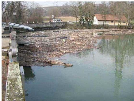
Photo 15 : Accumulation de bois au niveau du barrage de Verbois, (Services Industriels de Genève, 2006)
