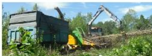
Photos 1 : Déchetage d'arbres entiers sur coupe
